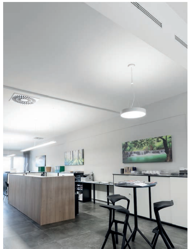
Troyer Fliesen & Marmor GmbH, Innsbruck, EDMUND SPARER Klima & Kältetechnik GmbH
