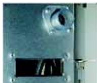
Otvor pro revizi vany kondenzátu
